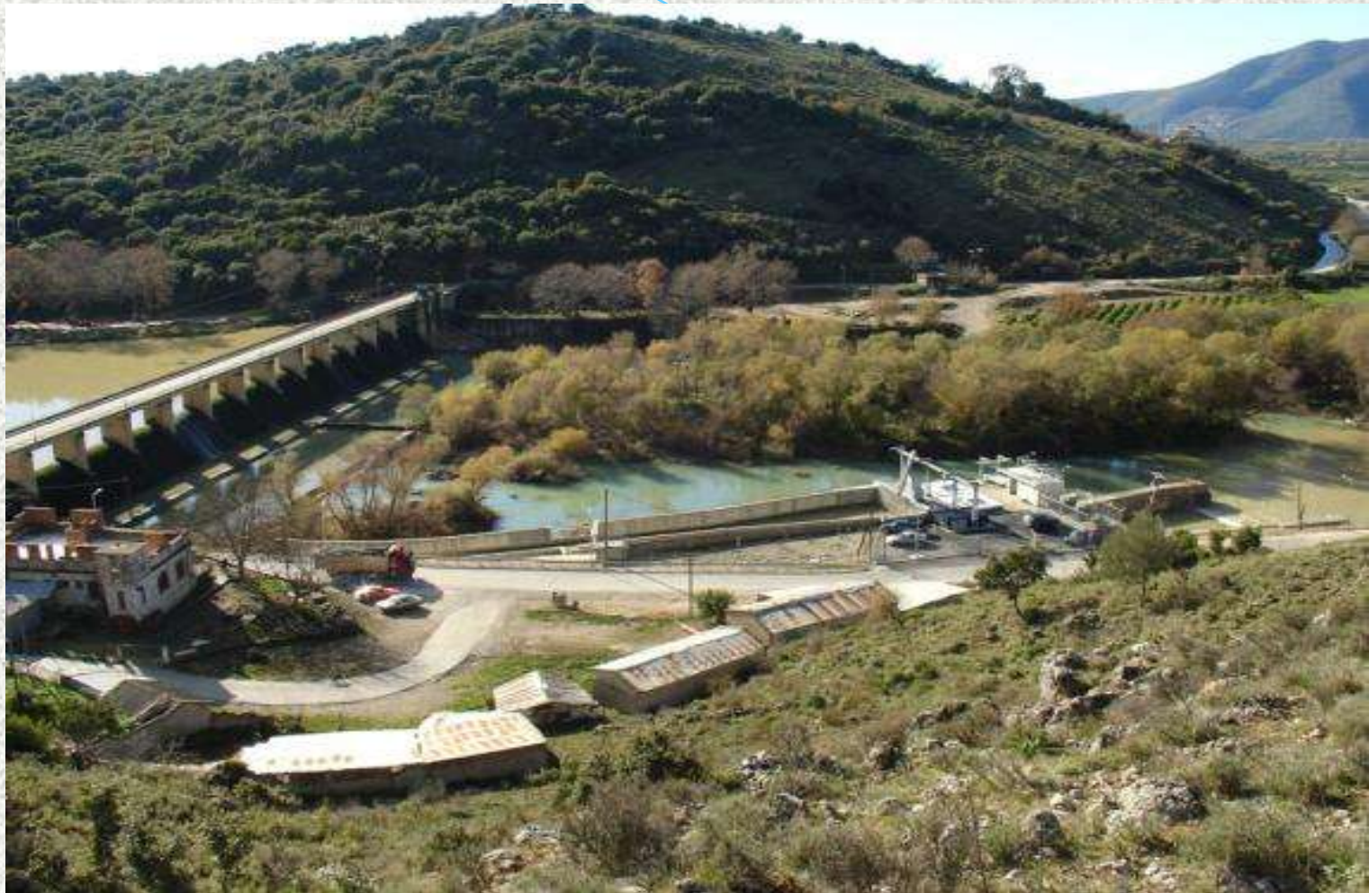
Άποψη του υφιστάμενου ΜΥΗΕ Γιτάνης επί του αρδευτικού φράγματος στον ποταμό Καλαμά
