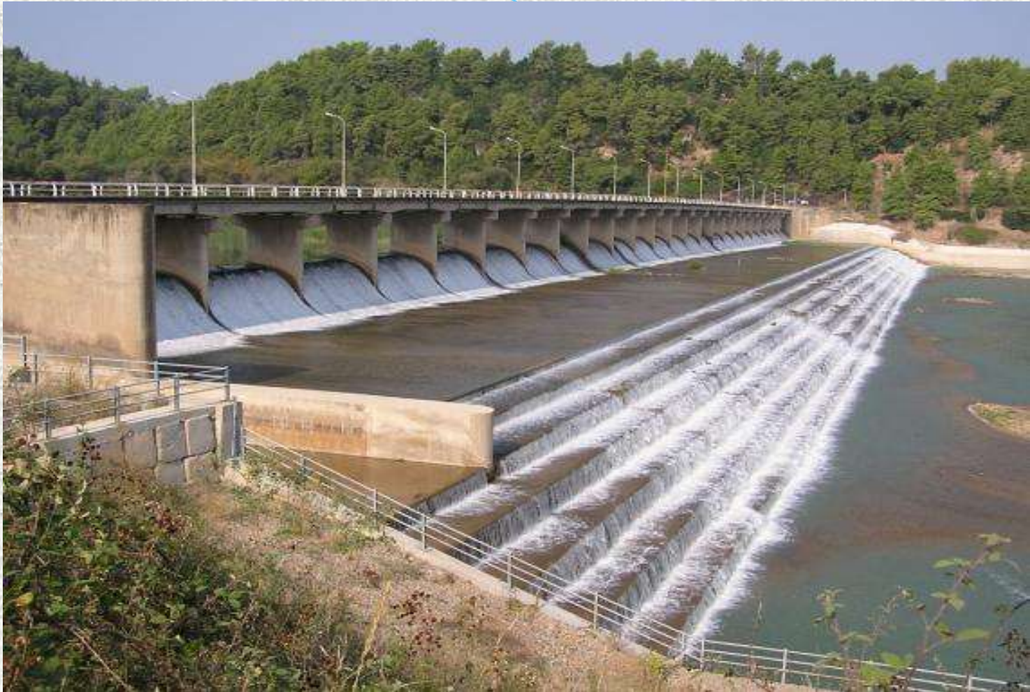
Άποψη του υφιστάμενου αρδευτικού φράγματος στον Αλφειό ποταμό
